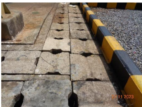
ภาพที่ 2.2-9 รางระบายน้ำฝนภายในพื้นที่โครงการ
