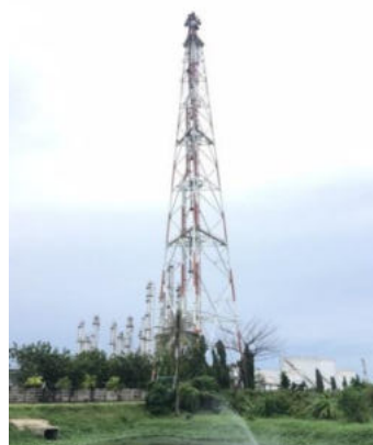
ภาพที่ 2.2-3 หอเผาที่จ้งระดับเหนือพื้นดิน (Elevated Flare)
